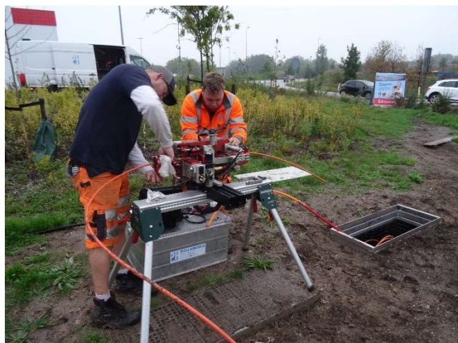
Petri & Haugsted A/S på opgave med at indblæse et 2.800 meter langt fiberkabel langs Ring 3 i forbindelse med etablering af Hovedstadens Letbane. Kristopher Viklund (tv) og Nicolai Granum er ved at opsætte et Jetting MJet V3 indblæsningsværktøj til fremføring af kablet.
