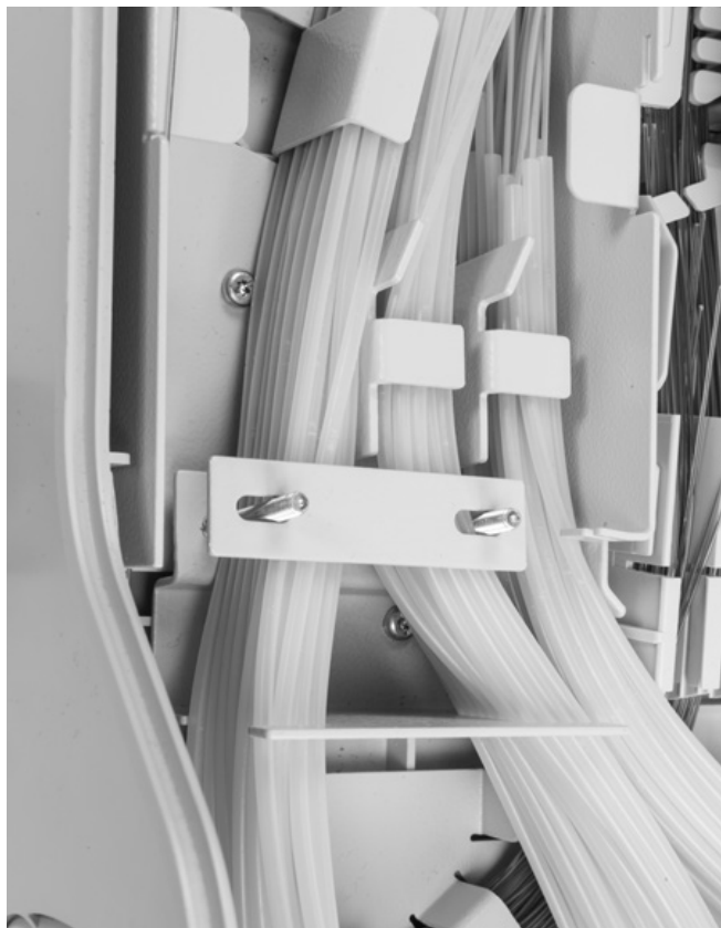
4.1 Rørene fra PTS'erne tages ud af overlængdeboksen. Fibrene blæses efter lokal instruks. Derefter placeret og fastholdt rørene igen i overlængdeboksen.
