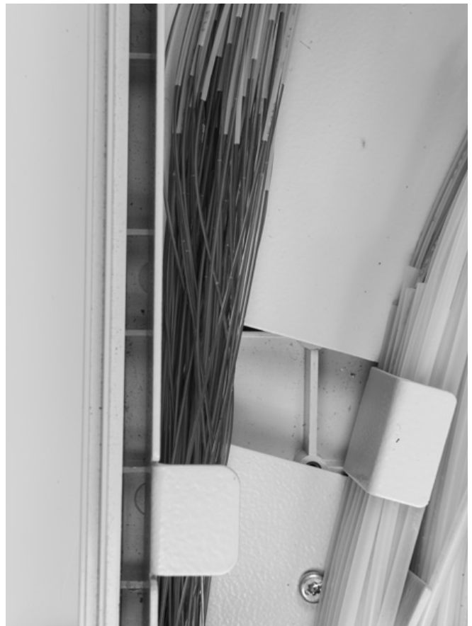
4.3 Den gule coating ringskæres og aftages lige efter den øverste venstre flap på overlængdeboksen. Se billede. Benyt kun godkendt værktøj.
