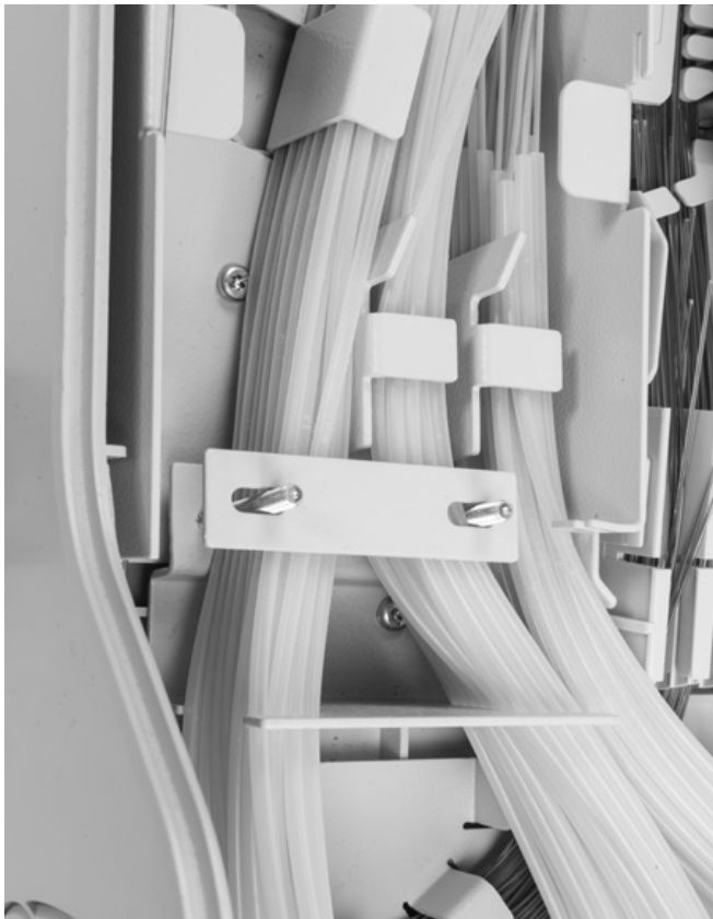
3.4 Første, anden og tredje PTS-6's rør ført til overlængdeboksen og fæstnet.
