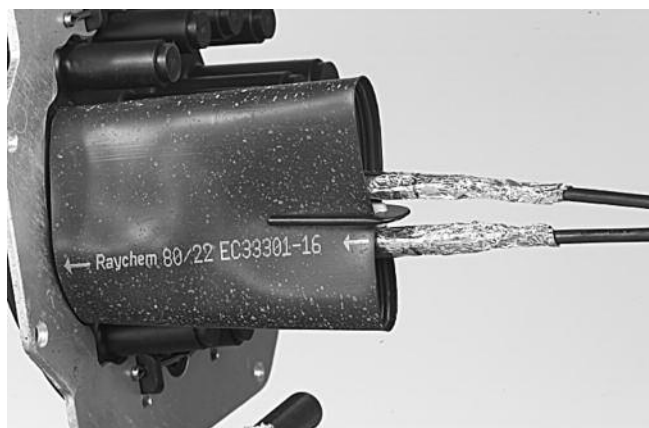
5 Skub krypemuffen op mod basen og monter limclipsen.
